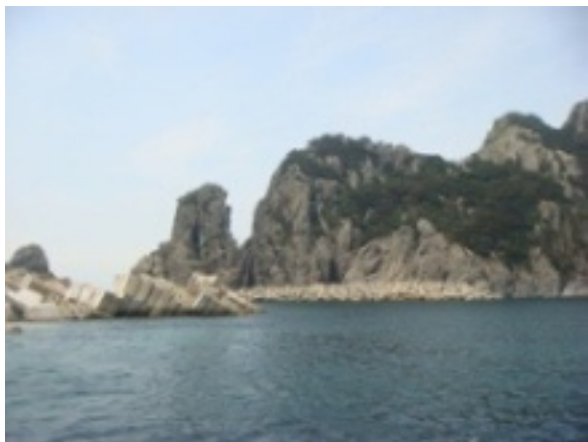
台風で破壊された防波堤
